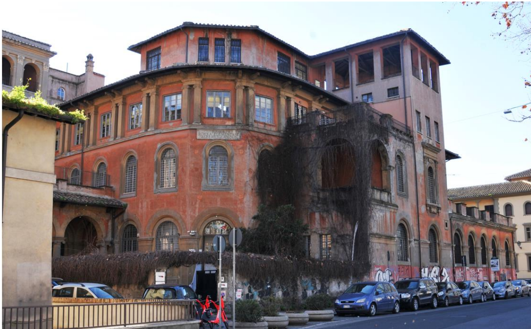
Scuola "A. Cadlolo", vista dal Lungotevere Tor di Nona (Gennaio 2021)
